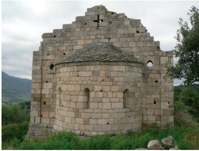
1. Vue du chevet de la ruine de l'église San Giovanni di Ciarca.
