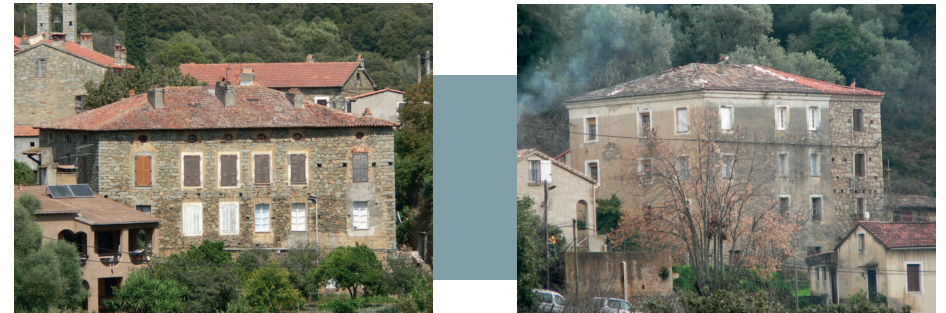
Maisons de notable à Casaglione, 1 er quart 19 e siècle et à Arro, 18 e siècle, agrandie au 20 e siècle.
