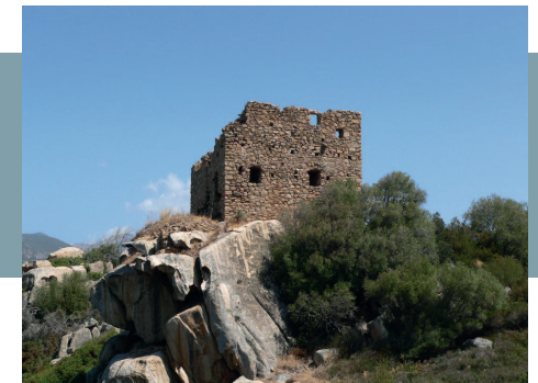
Page de gauche : vue du site du Castellu di Cinarca. Page de droite : vue de la maison forte de Cannelle ; vue des deux tours à Casaglione.
