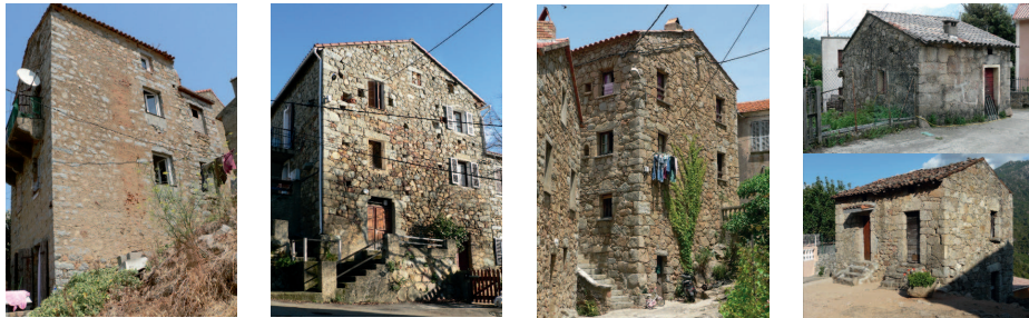
Casaglione, maison tour ; Ambiegna, maison 1733 ; Calcatoggio, maison 17 e -18 e siècle ; petites maisons à Pastricciola 1913 et Rezza 19 e siècle.
