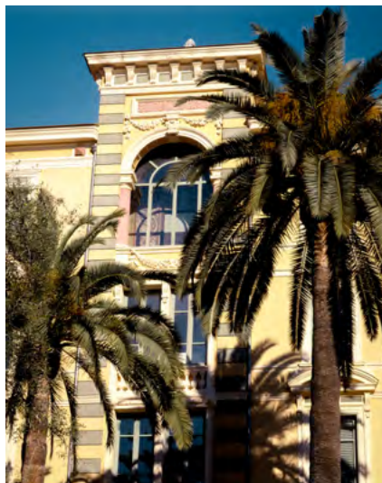
Ci-contre et ci-dessus : Façade de la Collectivité de Corse
