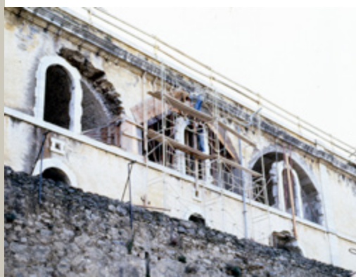
04. Chantier du musée de la Corse © CdC, Direction du patrimoine/DR
