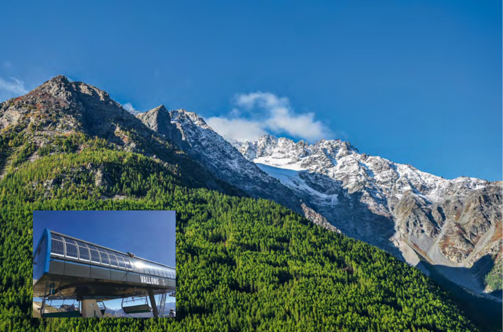
Panneaux solaires sur les toitures des gares de remontées mécaniques de Serre Chevalier.
