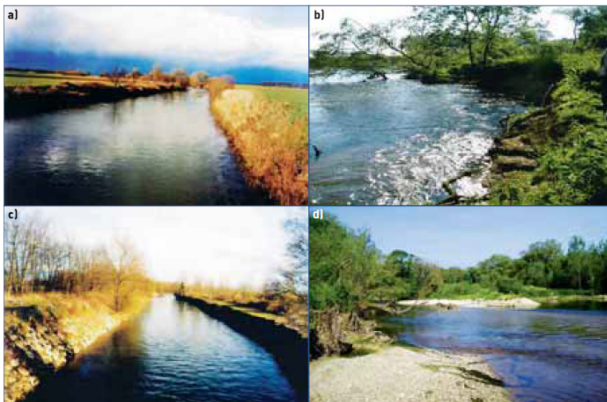
Exemple de morphologie de l'Ouche dans les portions endiguées, recalibrées, rectifiées (a et c), et dans les portions où les berges ont repris leur état naturel (protections non reconstruites (b et d))
