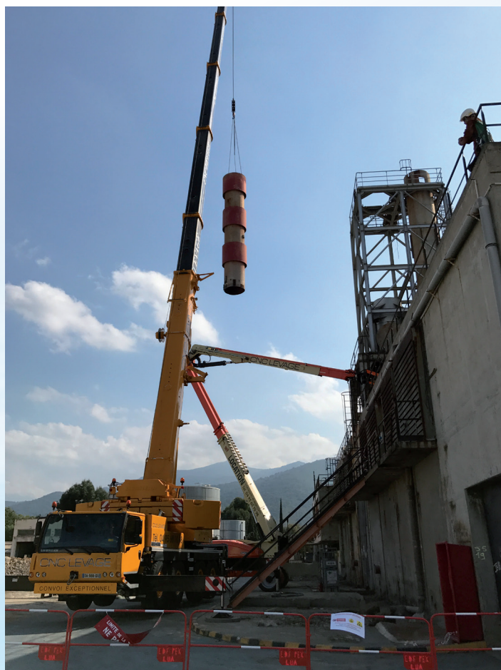
Démontage des cheminées de la centrale thermique de Lucciana Juin 2017.
