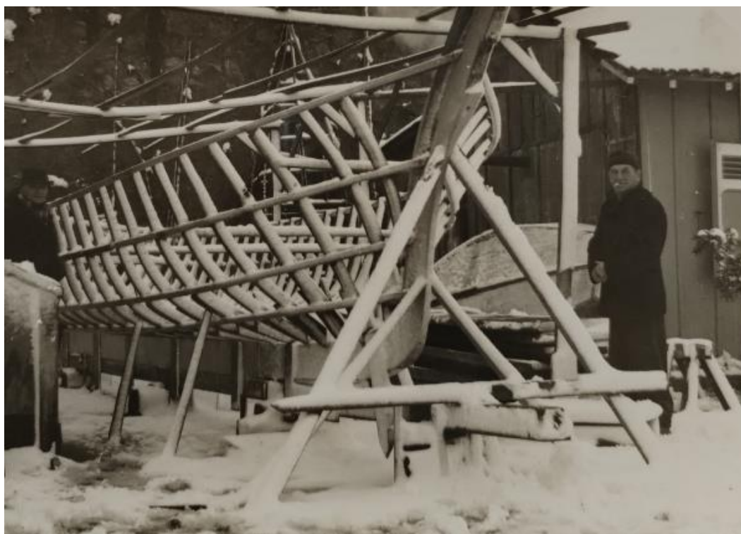
Chantier Nobili sous la neige lors de la construction de la felouque
