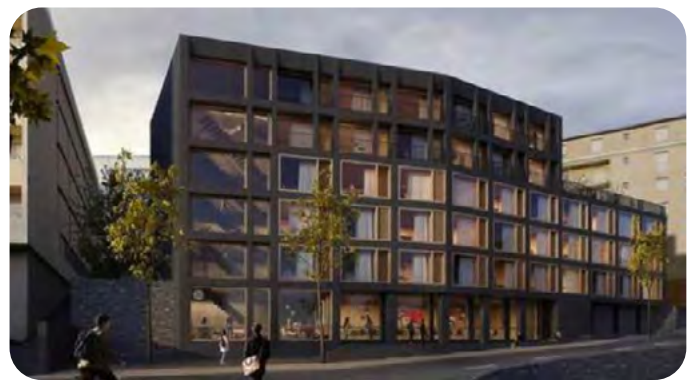
La future résidence étudiante « SAMBUCUCCIU D'ALANDU » à Corti, financée à hauteur de 2 millions d'euros par la Collectivité de Corse
