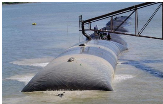
Remplissage d'un boudin en géotextile
