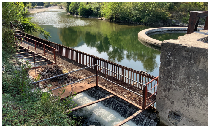
Ouvrage de prise actuel (vue amont)
