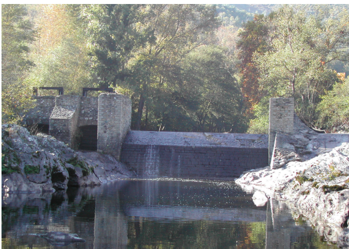
Ouvrage de prise actuel (vue depuis l'aval)
