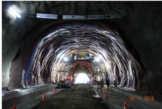
Figure 12 : mise en œuvre de l'étanchéité dans le tunnel
