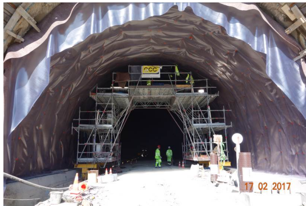
Figure 13 : fin de l'étanchéité – tête Sud
