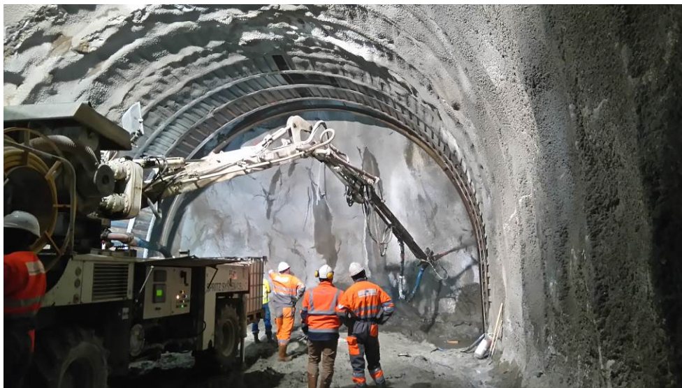
Figure 11 : Projection du béton avec robot
