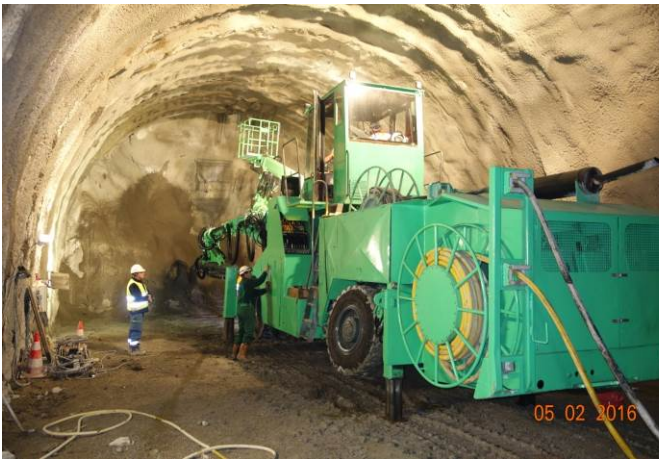
Figure 9 : Réalisation des forages
