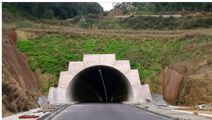
Figure 19 : Tête Nord – photo prise en cours d'aménagement
