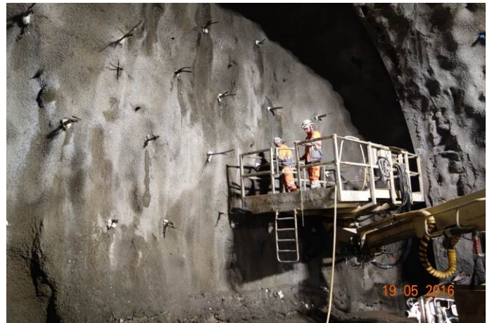
Figure 10 : Chargement des explosifs
