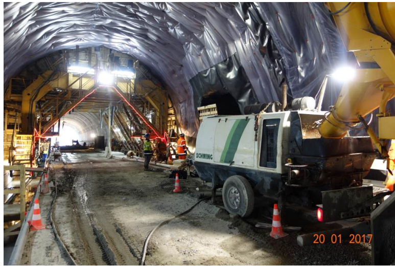
Figure 15 : outil coffrant dans la section creusée
