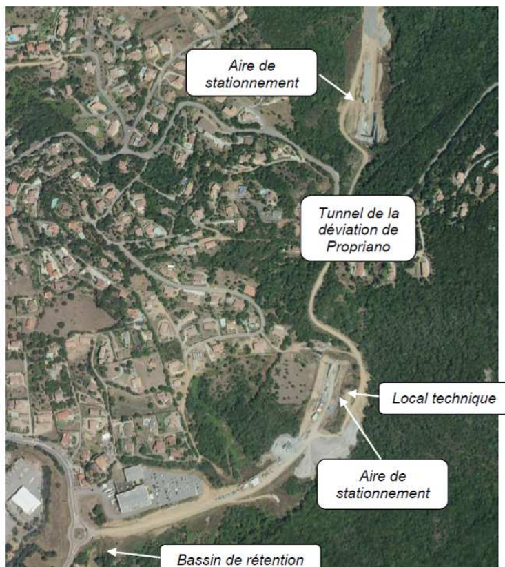
Figure 17 : Aménagements aux abords du tunnel
