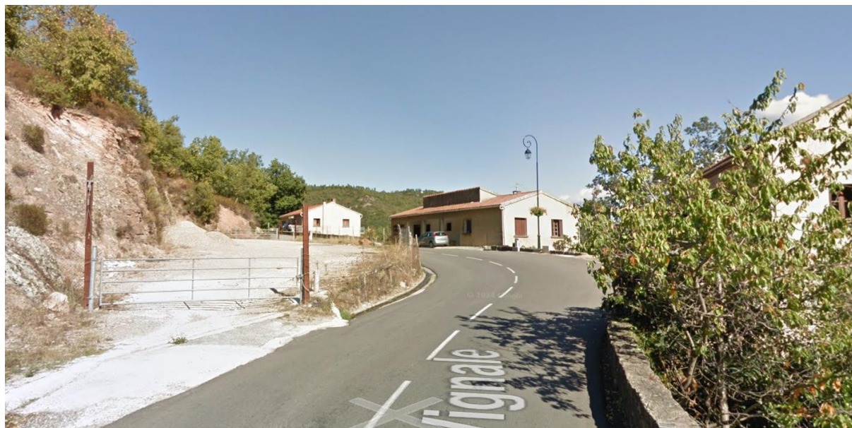
Courbe à rectifier en sortie Nord
