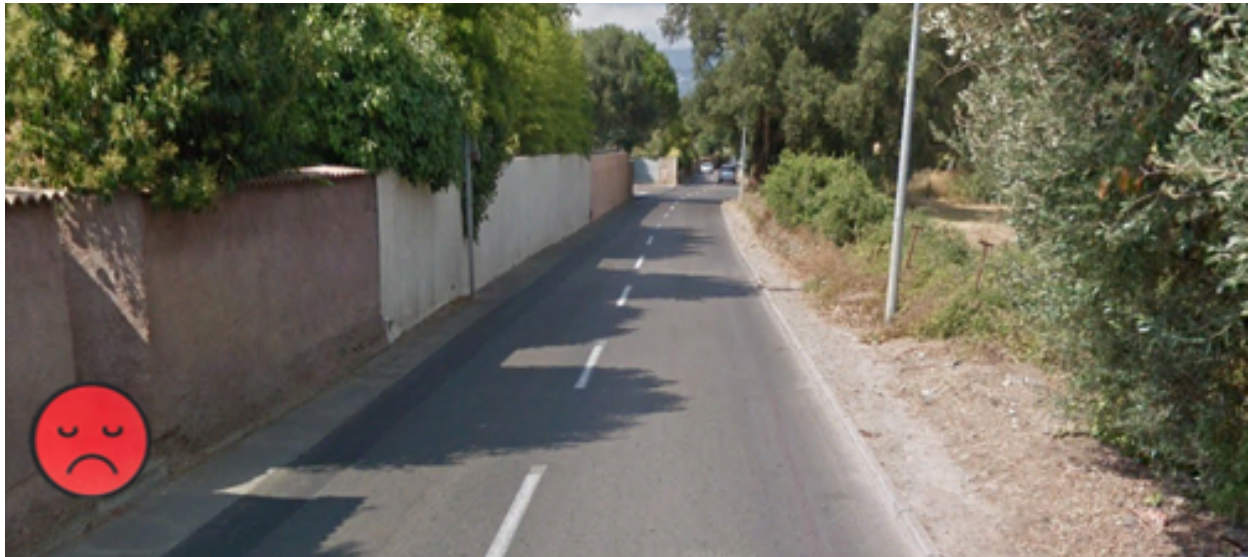
Absence de cheminement piéton, absence de réseau d'assainissement pluvial
