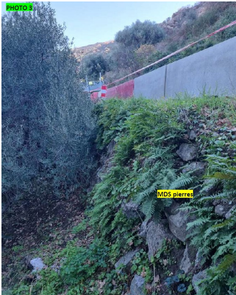
Figure 2 : Vue talus aval au pk 30.270
