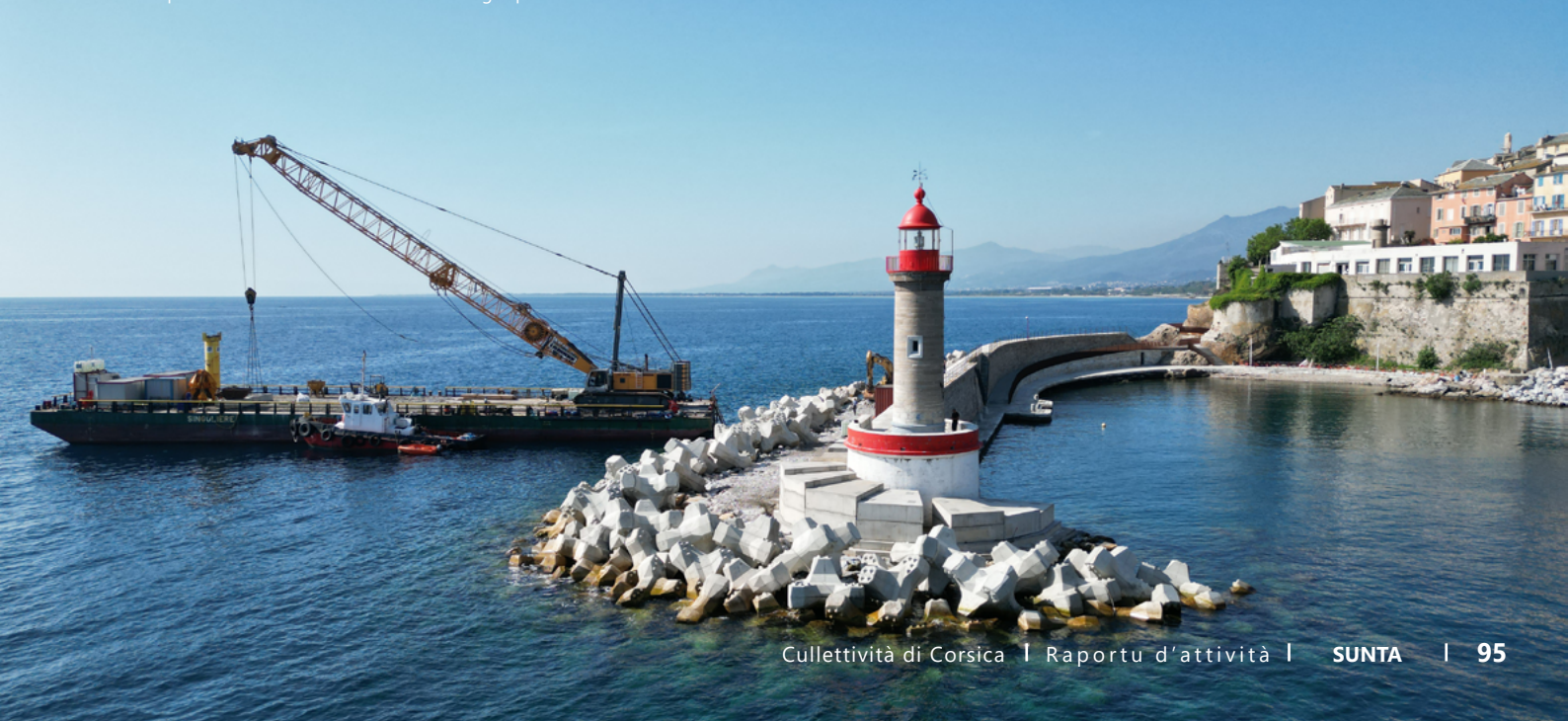
Travaux de réparation et de confortement des ouvrages portuaires et maritimes de Bastia
