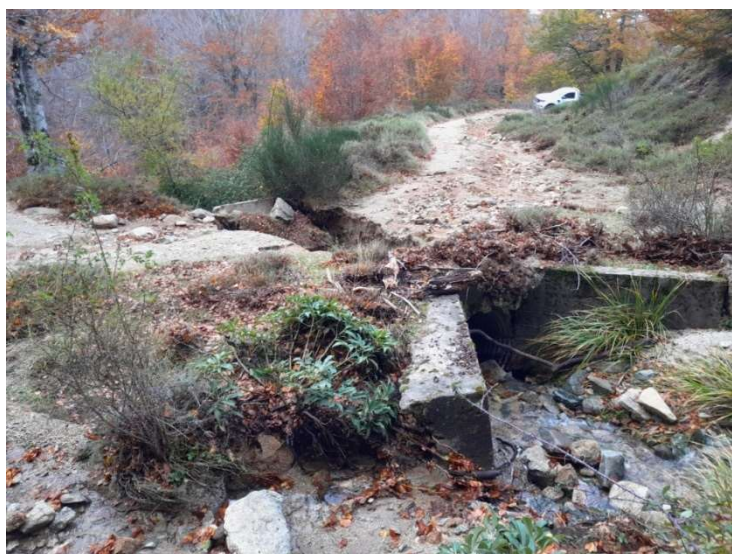
Piste de Sistaghja, destruction de l'ouvrage suite à la tempête, (ruisseau de Valpine MAO, ONF 2023)
