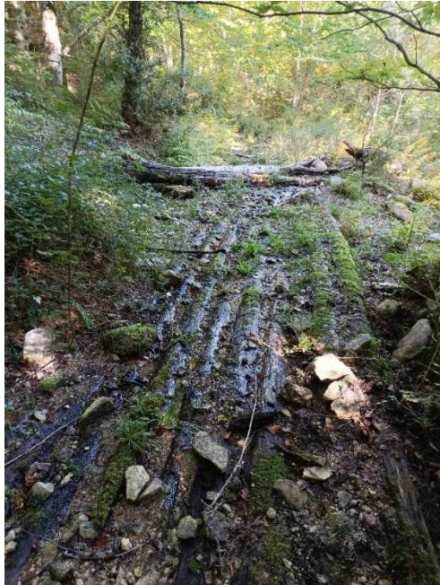
Ouvrage des années 50 pour franchissement cour d'eau, (parcelle 3, JPB, ONF 2023)
