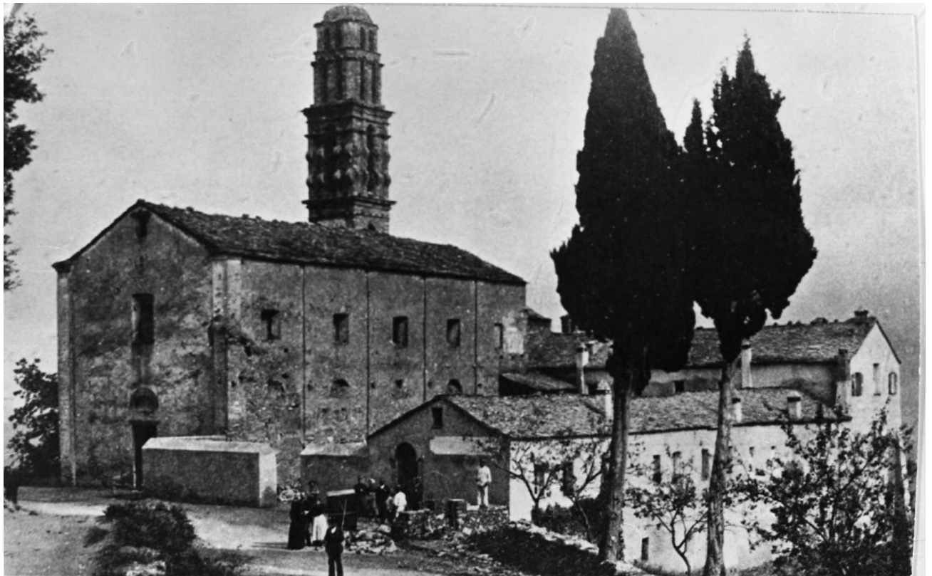
Vue du couvent avant destruction partielle, début XXe – Collectivité de Corse, service inventaire
