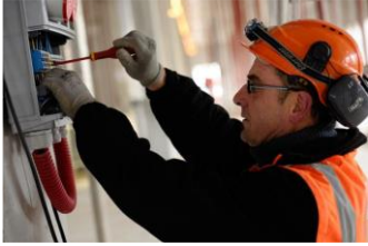
Installation d'un éclairage provisoire avec branchement sur une armoire électrique murale
