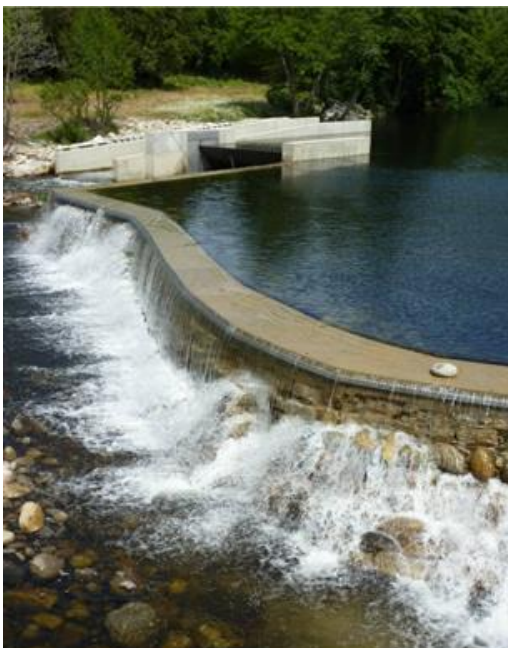
Corse Energia – Mini centrale de type basse chute sur le Taravo à Casalabriva
