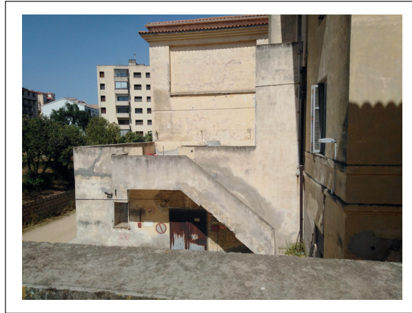
Bâtiment A, façade Nord
