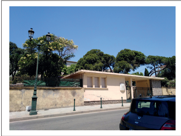
Entrée depuis le boulevard Albert 1er
