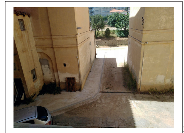
Cour arrière du bâtiment A
