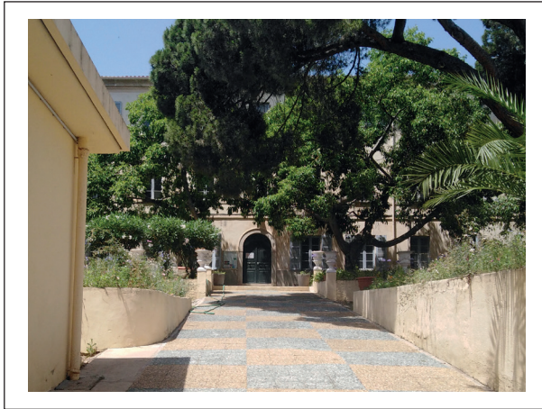
Bâtiment A, vue depuis l'entrée
