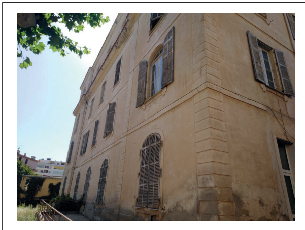
Bâtiment B, façade Sud
