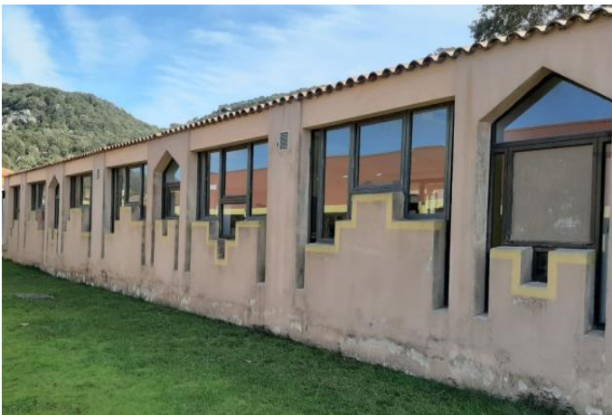
Façade extérieure, menuiseries
