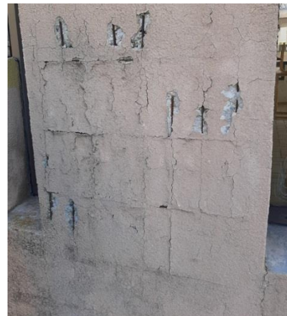
Etat du mur extérieur
