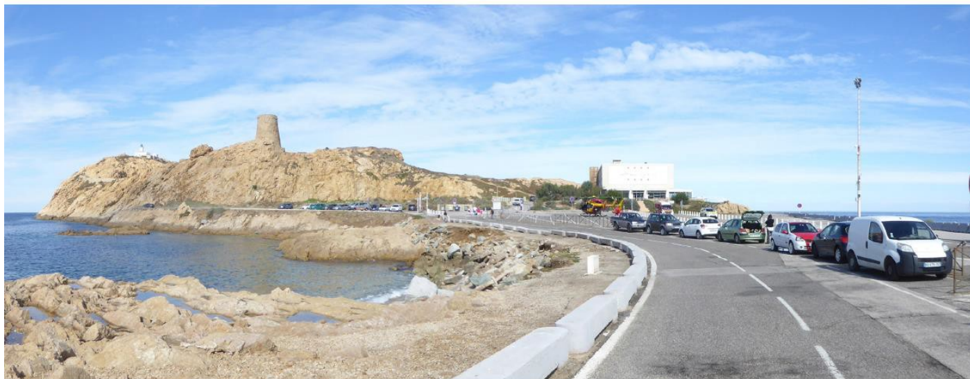
Etat des lieux. Vue depuis la traversée de la route au droit de la gare maritime.
