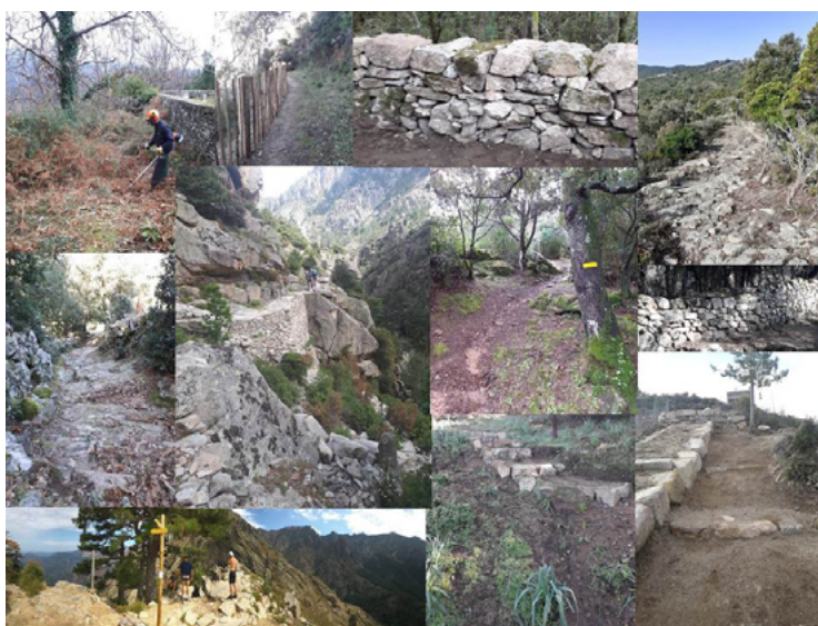
Travaux d'aménagement, de sécurisation et de mise en valeur de chemins de randonnée
