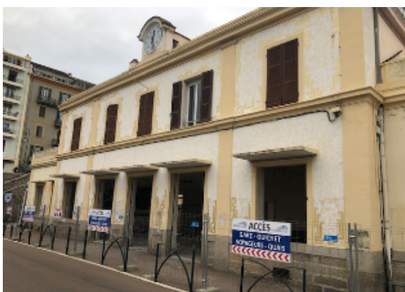
Travaux de la gare d'Aiacciu
