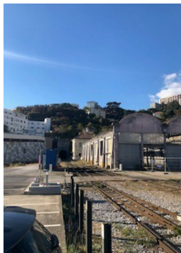
Démolition de l'ancien dépôt ferroviaire de Bastia
