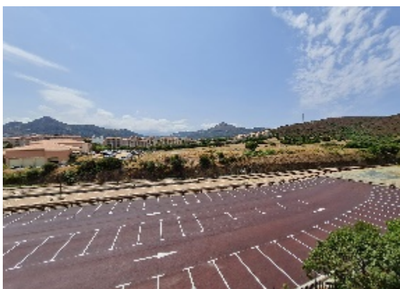
Nouveau parking à la gare d'Isula Rossa
