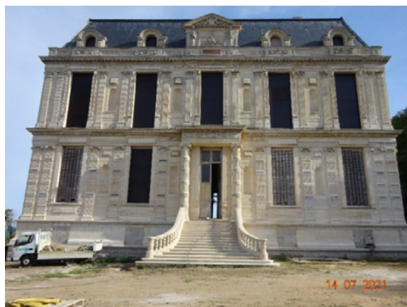
Travaux de 1 ère urgence du Château de la Punta
