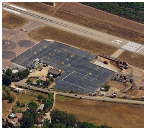
Aéroport de Calvi - travaux extension d'aviation d'affaires / générales
