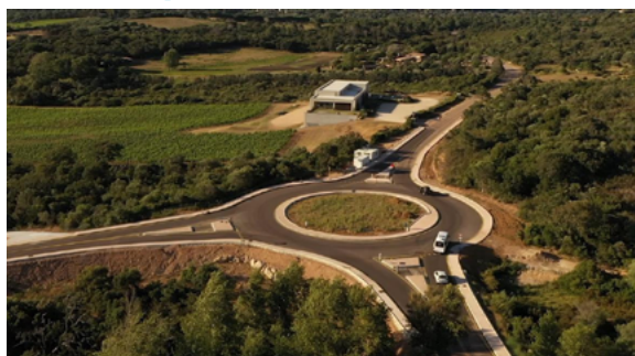
Déviacion de Figari - poursuite des travaux
