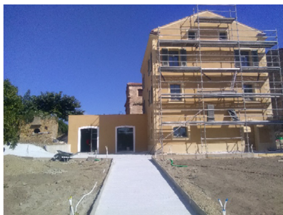
Réhabilitation de la Maison Rossi - Aléria
