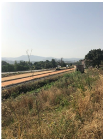
Réalisation d'un point de croisement de Calanica
