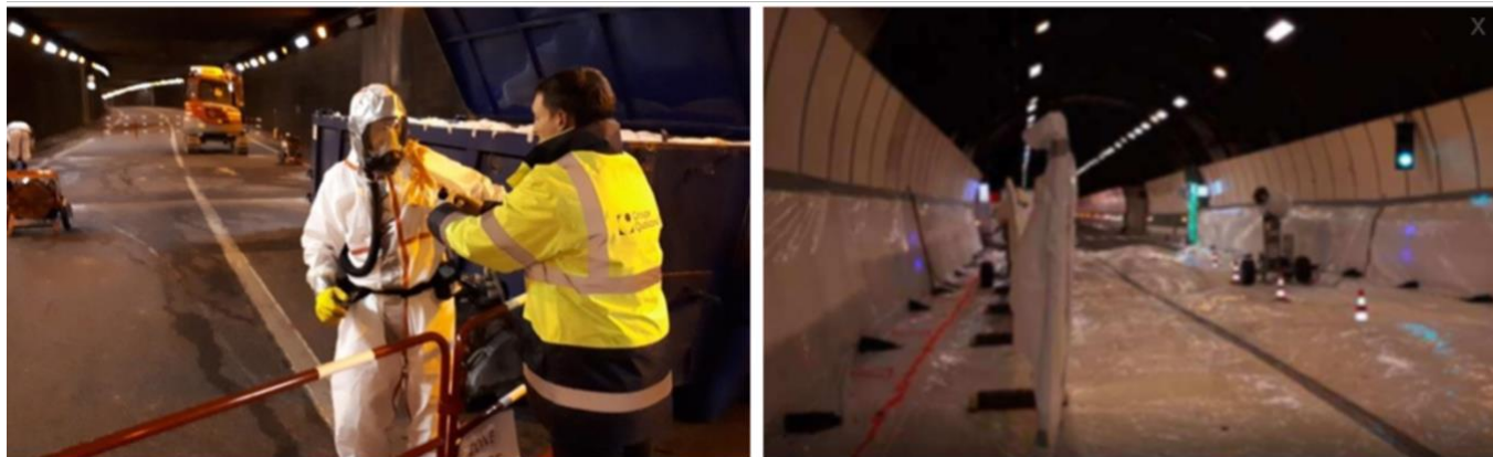
Combinaisons étanches portées par les travailleurs et dispositif de brumisation
