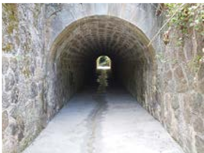
Réfection d'un radier à Venacu
