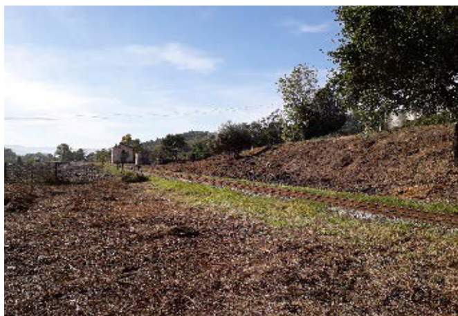
Débroussaillage du point de croisement de Caldaniccia
