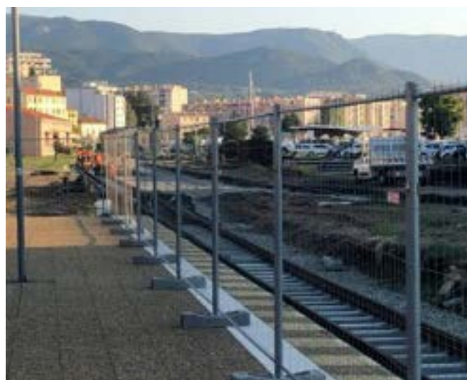
Rénovation des voies à Ajaccio
