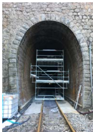
Chantier de régénération de tunnel
