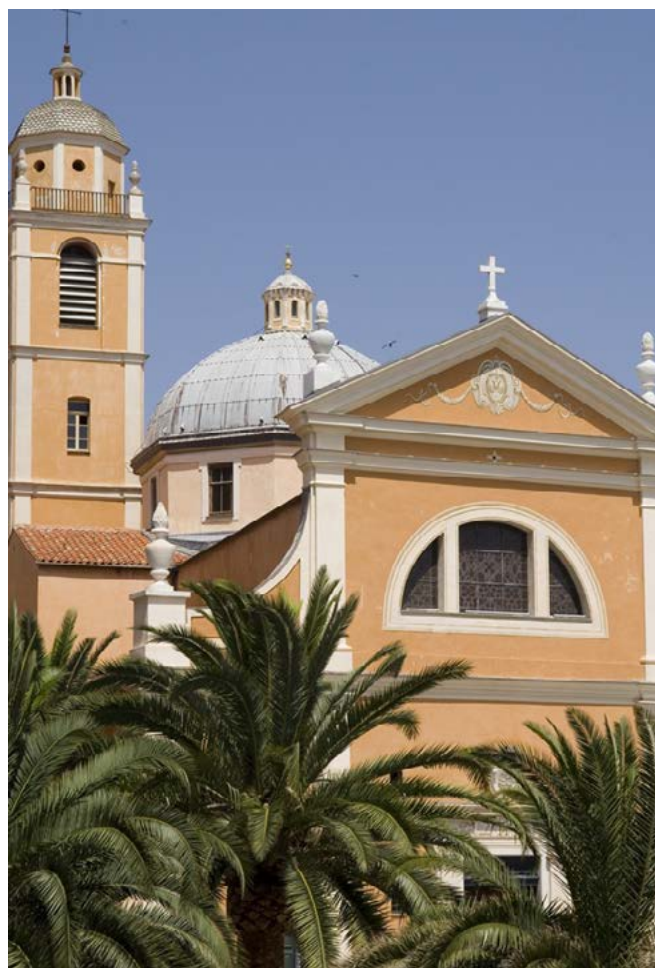
Travaux d'entretien et de réparation du dispositif de fonctionnement des cloches de la cathédrale d'Aiacciu
