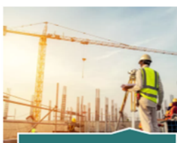
Déchets du BTP
