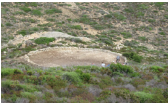
Aménagement Revelatta et restauration d'une aghja
