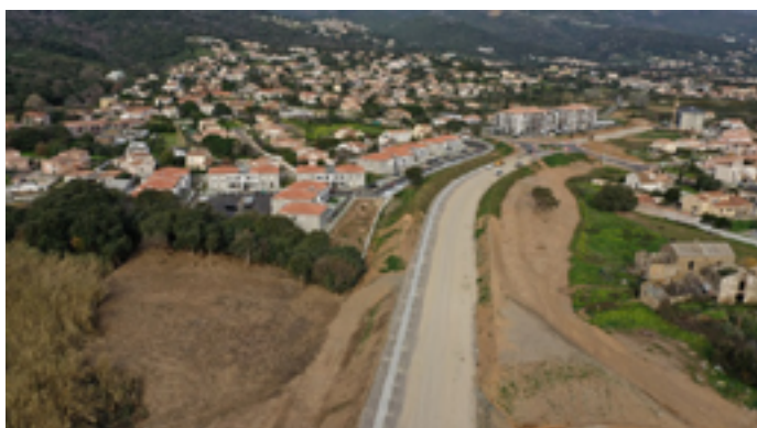
Création de la voie nouvelle Bastia-Furiani
