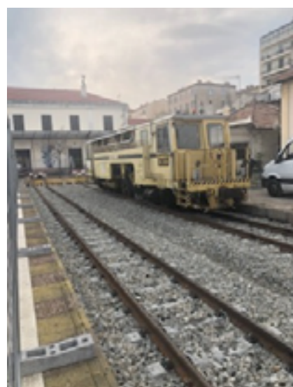
La gare d'Ajaccio : travaux de renouvellement d'une partie des voies
