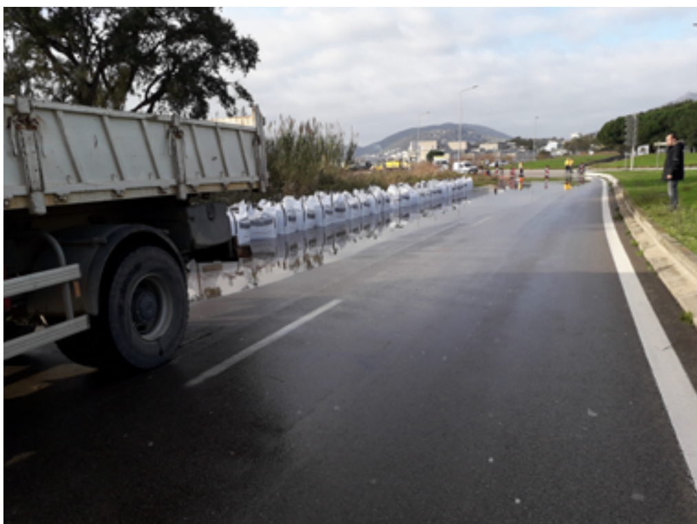
La mobilisation de la Collectivité de Corse lors des intempéries de décembre 2019 (giratoire de Campo dell'Oro)
