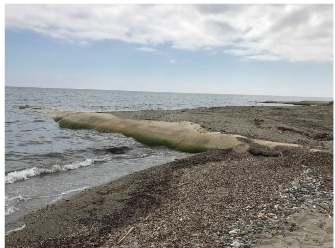
Illustration 19 : Epis en géotextile – Secteur de Moriani
