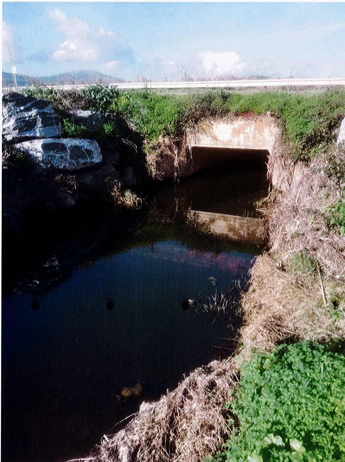
Vue partielle de l'ouvrage hydraulique en limite Nord de la parcelle AX 38
