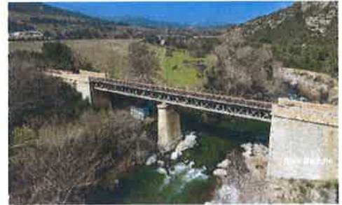
Vue aérienne d'ensemble
