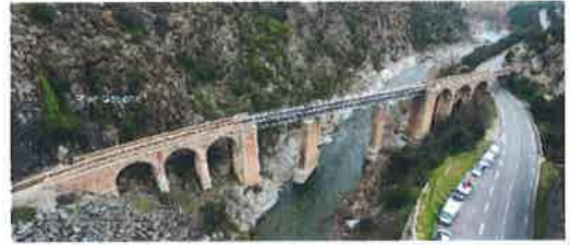
Vue aérienne d'ensemble
