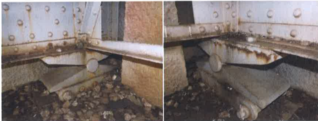
Vérinage et protection anti-corrosion des appareils d'appuis sur culées (Muzzelle)
