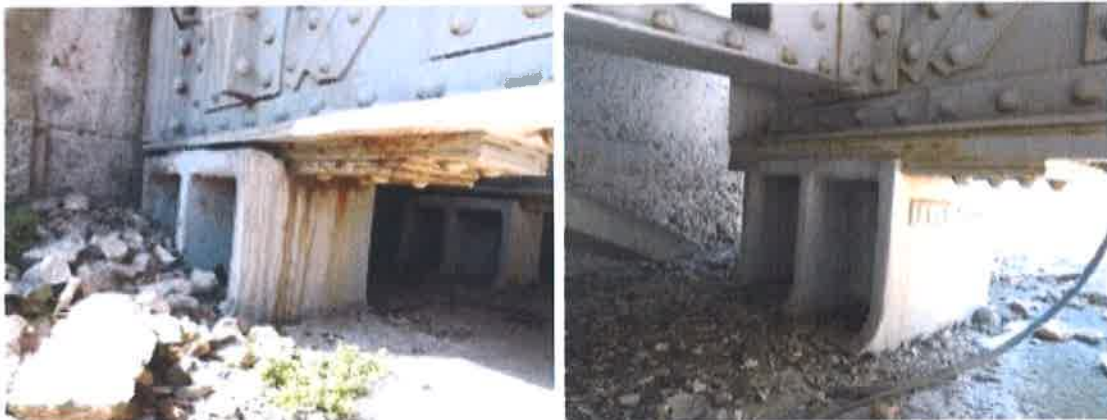
Nettoyage des appuis (Albano)
