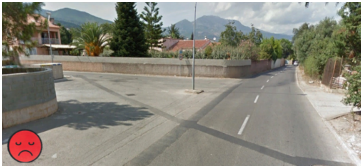
Manque de lisibilité sur le carrefour, absence de cheminement piéton, absence de réseau d'assainissement pluvial
