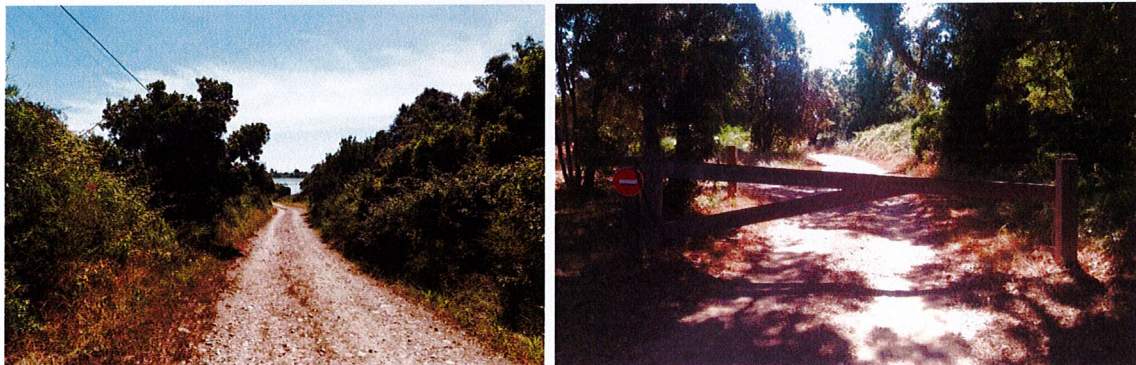
Figure 12 : piste de service et barrière d'accès.
