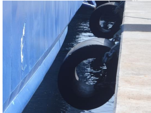
PRO 05 – Inspection visuelle des défenses cylindriques
