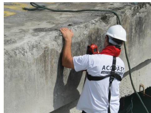
Recherche d'armatures par pachomètre
