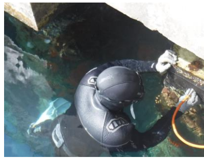
Prise de mesure sur rideau mixte au travers du revêtement
