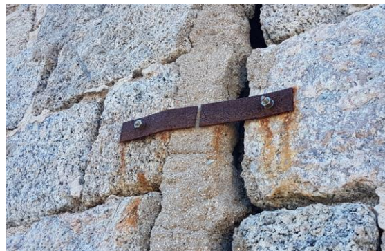
Plaque de suivi sur le mur de la digue du large
