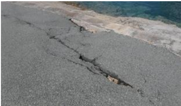
Vue de l'enrobé fissuré/affaissé à l'arrière du couronnement en béton
